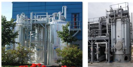
Figura 4. Instalações de Hidrólise Térmica em Atenas e Frederica
