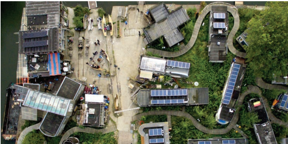
Zdjęcie 1.1. Widok zabudowy w De Ceugel
