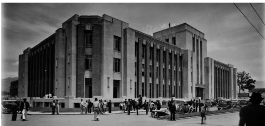
Ilustración 16: Palacio Municipal de Medellín Fuente: Archivo Fotográfico Biblioteca Publico Piloto
