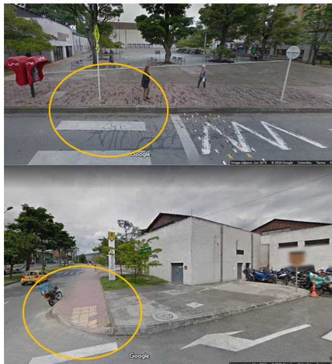
Ilustración 36: Accesibilidad Belén Fuente: Google maps 2020
