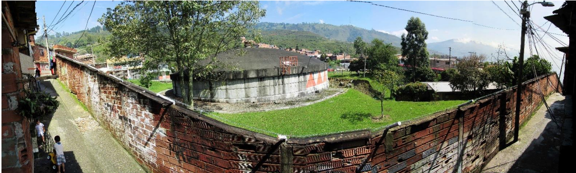
Ilustración 68: Estado de los tanques de agua EPM antes de la intervención Fuente: Departamento de Intervenciones Urbanas Sostenibles - EPM
