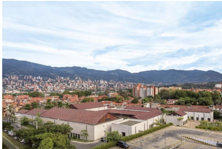
Ilustración 42: Parque Biblioteca de Belén Fuente: Archello
