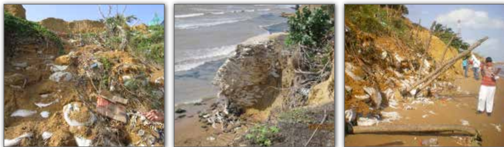
Figura 8. Microvertederos y formas de contención de los taludes
