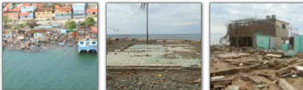
Figura 13. Daños en viviendas debido a la penetración del mar del huracán Sandy a su paso por Santiago de Cuba
