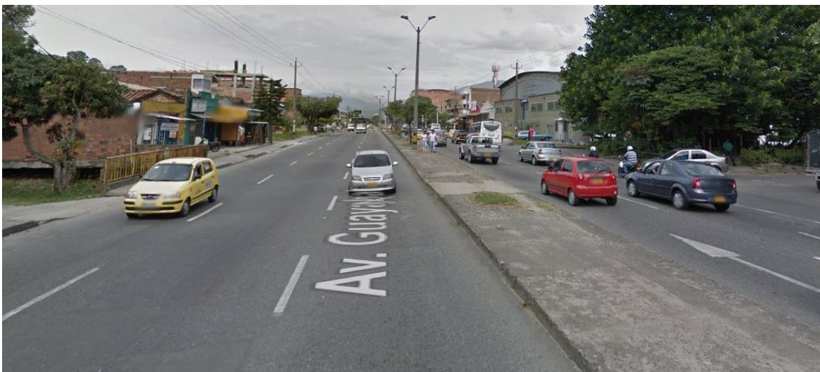
Figura 58. Configuración de la Avenida Guayabal. Fuente: Google Street View .
