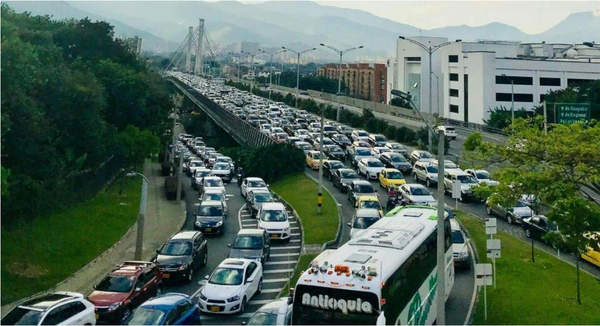
Figura 64. Configuración del puente Gilberto Echeverri (calle 4 sur), 2017. Foto: Gustavo Alonso Cabrera.
