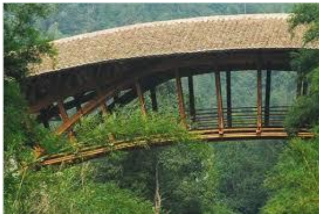
Imagen 6 Uso de diferentes partes del bambú en construcción de puente Jenny Garzón
