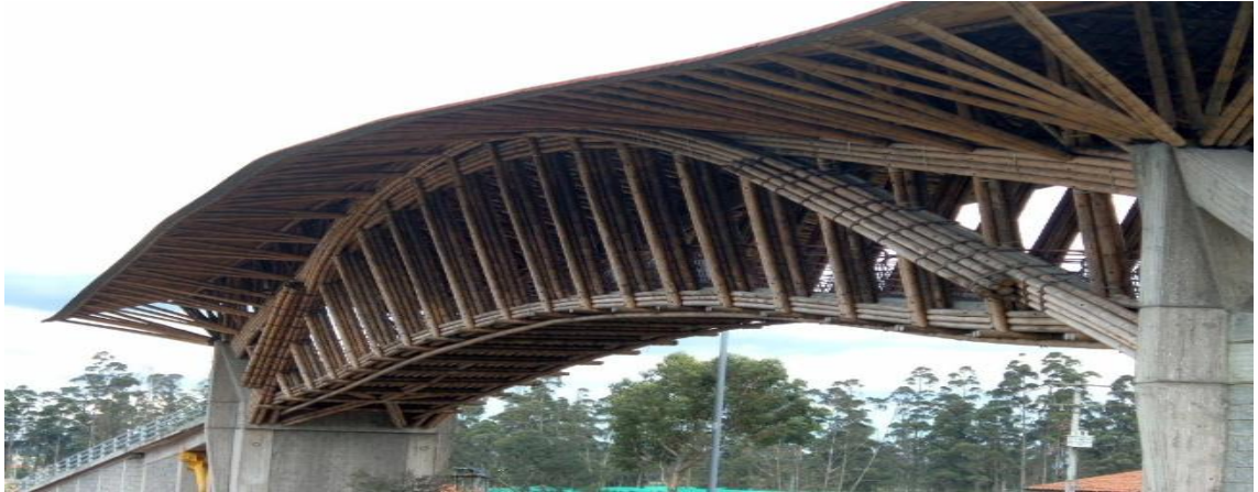
Imagen 12 Puente realizado en guadua
