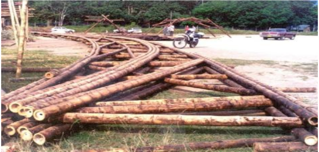
Imagen 15 Montaje de cercha.
