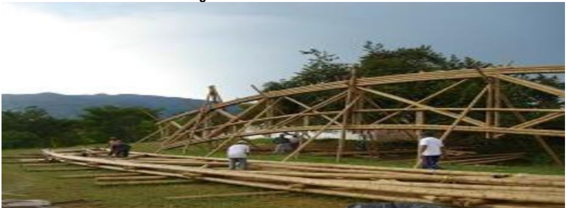
Imagen 16 izado vertical de la cercha
