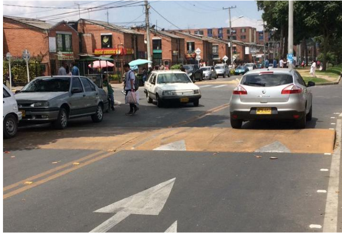
Imagen No. 2. Resaltos en concreto.
