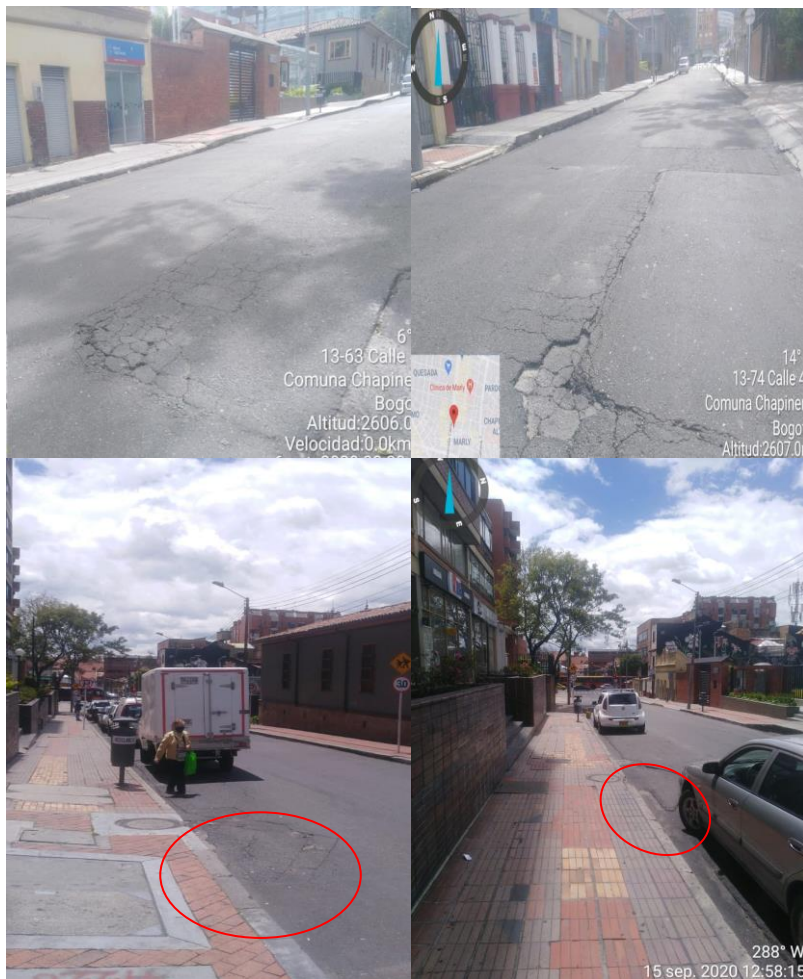
Imagen No. 10. Estado actual del corredor vial.
