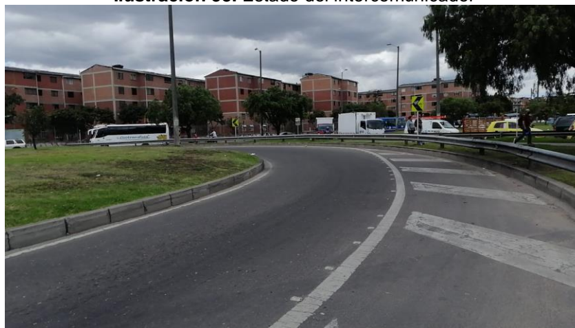
Ilustración 38. Estado del intercomunicador
