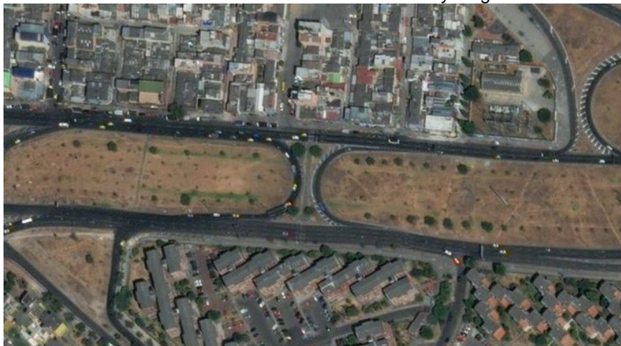
Ilustración 40. Vista del intercomunicador y diagonal 2.
