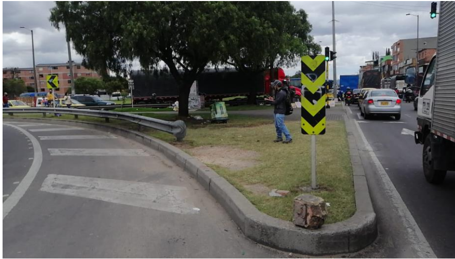
Ilustración 39. Estado del intercomunicador y diagonal 2.
