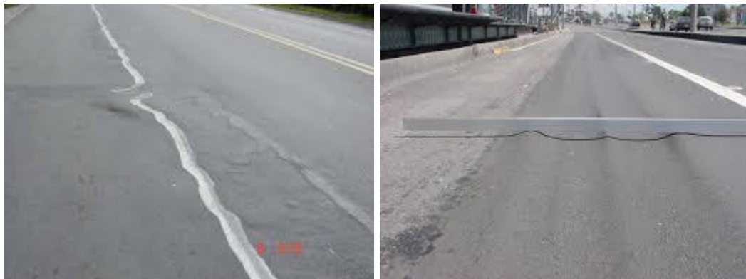
FIGURA 14. AHUELLAMIENTO SUBRASANTE
