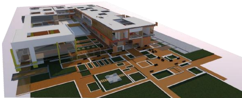
Figura 33–Render Fachada SUR del edificio
