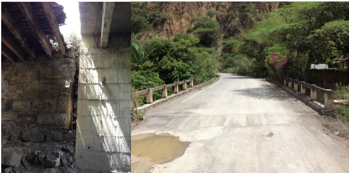
Figura N°31 Pontón dos quebradas K8+804 Vía Soata -Puente Pinzón
