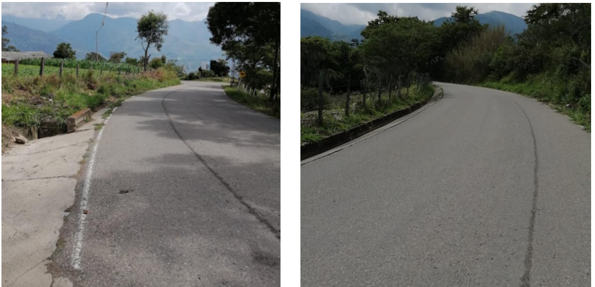
Figura No 23 Fotografía vía Soata –Puente Pinzón K0+400 y K0+300
