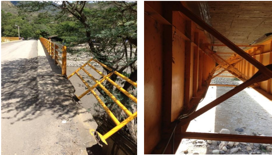
Figura N°39. Puente Pinzon Soatá
