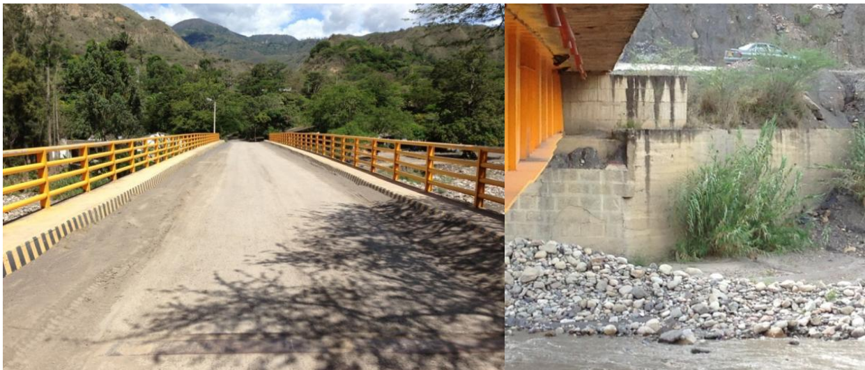
Figura N°32 Puente Pinzón K9+530 Vía Soata -Puente Pinzón
