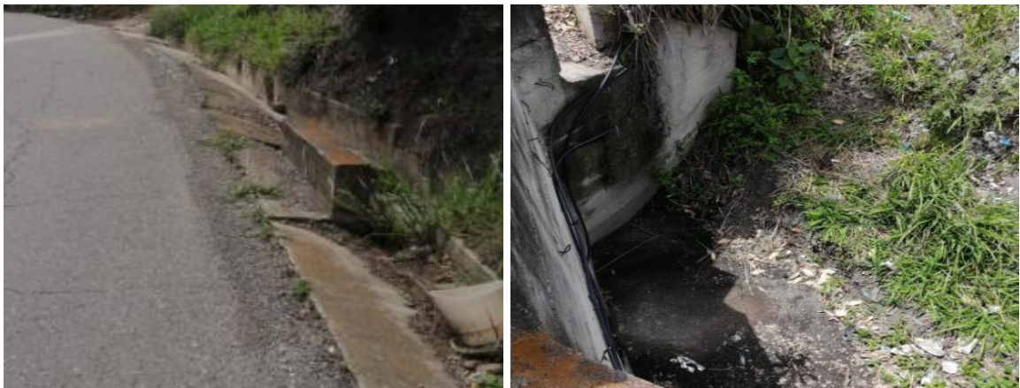
Figura N°38. Estado obras de arte Vía Soata – Puente Pinzón K0+200 y K0+600
