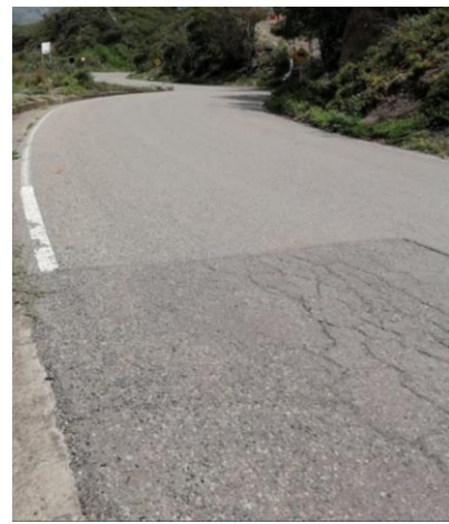
Figura N°7. Baches Carril izquierdo K0+230, y K0+700 Vía sentido Soata – Sector Puente Pinzón.
