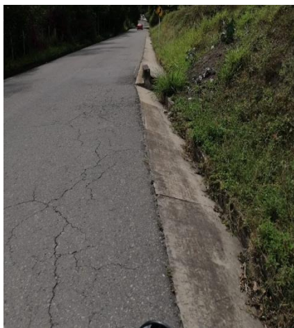
Figura N°7. Baches Carril izquierdo K0+230, y K0+700 Vía sentido Soata – Sector Puente Pinzón.
