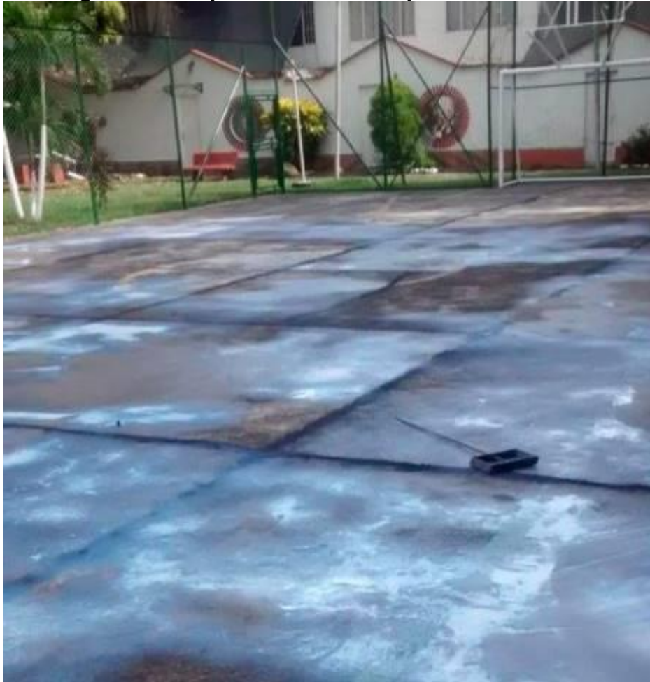
Fotografía 11. Imprimación de la superficie de la cancha
