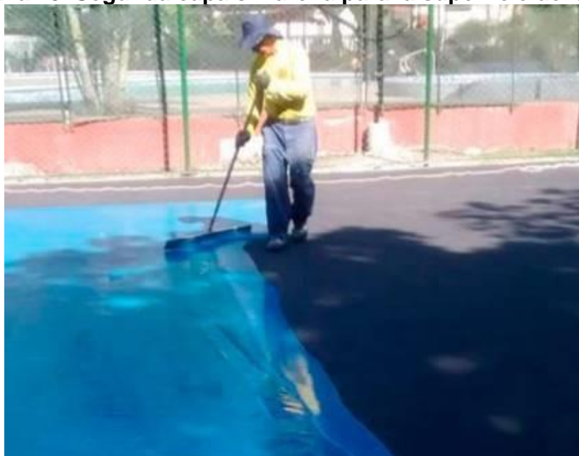
Fotografía 13. Segunda capa sin arena para la superficie de la cancha
