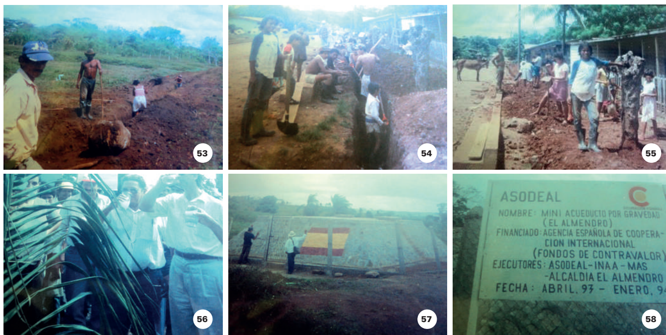
Fig.53-58: Las fotos de la parte superior muestran la actividad de zanqueo del proyecto de agua potable, protagonizada por la población de todas las edades, incluyendo mujeres y niños. En las fotos siguientes de izquierda a derecha, se muestra el momento en que aconteció la inauguración del primer proyecto de agua potable, la Pila de recepción de agua potable en el Barrio 17 de Julio y la placa del mini acueducto por gravedad de El Almendro.
