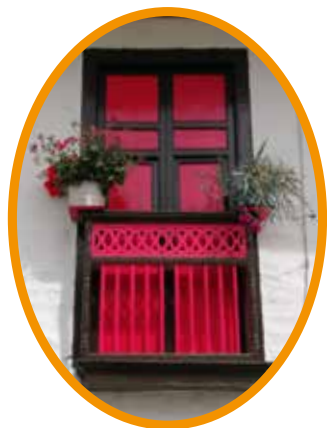
Figura 15. Puerta ventana con balcón y postigo.
