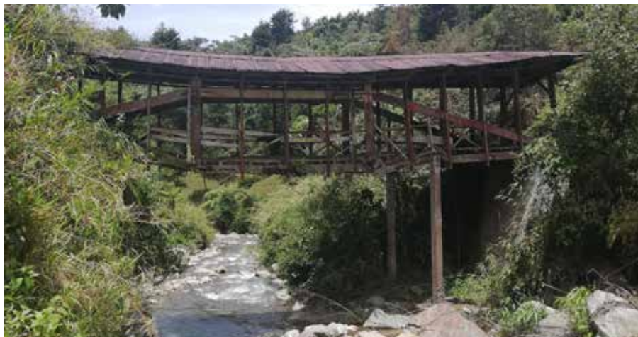
Figura 24. Casa Puente Las Brujas
