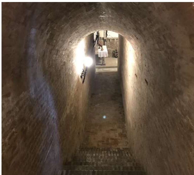
Figura 3.66: Detalle de la escalera de bajada a la Cripta de la Familia Alvear. (Fuente: fotografía de la autora).
