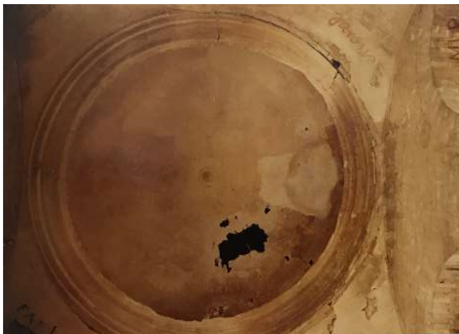
Figura 3.83: Detalle de la bóveda del campanario. (Fuente: A.C.C.C.P.H.A. A9.004/14, s.f.).
