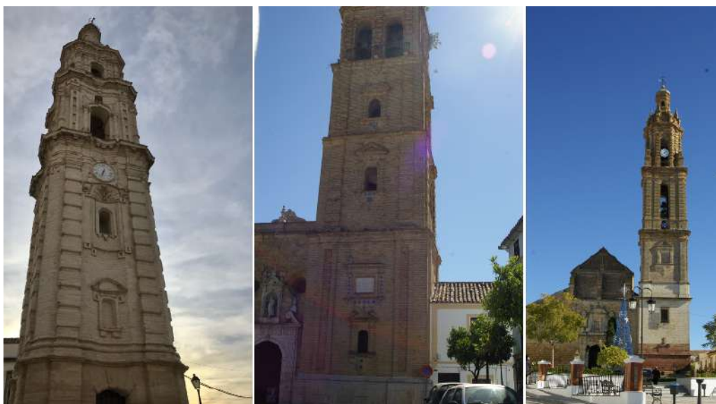
Figura 3.38: Torre del Reloj de Aguilar de la Frontera (izquierda), de la iglesia de Santiago de Montilla (centro) y de la iglesia de Nuestra Señora de la Asunción de Bujalance (derecha). (Fuente: fotografías de la autora).
