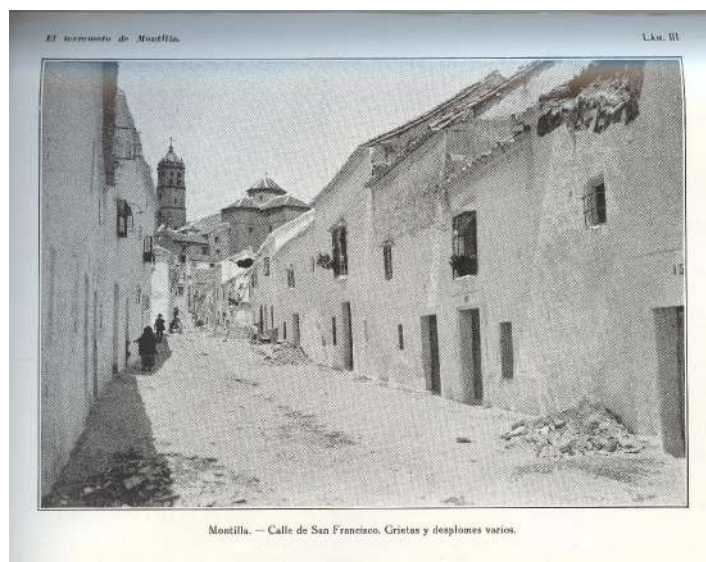
Figura 3.61: Vista de la calle San Francisco con la iglesia de Santiago al fondo tras el terremoto de 1930. (Fuente: F.B.M.R.L. (Num. Rgto 15230). Carbonell Trillo-Figueroa (1931). El terremoto de Montilla . Lám. III. Madrid: Instituto Geológico y Minero de España-Gráficas Reunidas).
