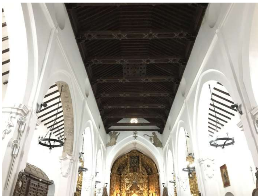
Figura 2.16: Artesonado de la iglesia de El Salvador de Pedroche. (Fuente: fotografía de la autora).
