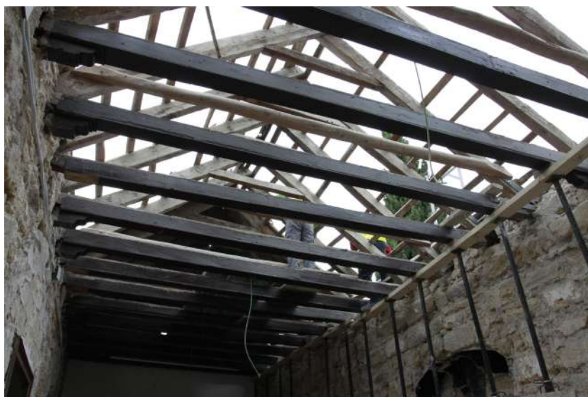
Figura 3.101: Detalle de la intervención sobre las cubiertas y armadura de la zona 2: “Sala de la Adoración Nocturna”. (Fuente: fotografía de Rafael Salido).
