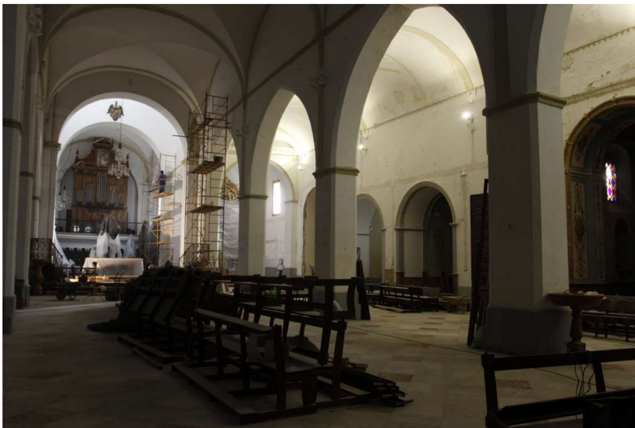
Figura F5: Detalle de la nave central y de la nave de la Epístola durante la intervención de 2013. Parroquia de Santiago Apóstol (Fuente: Rafael Salido).
