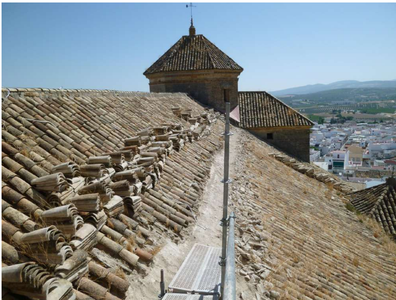
Figura 3.93: Intervención sobre la cubierta de la nave central. (Fuente: fotografía de Rafael Salido).
