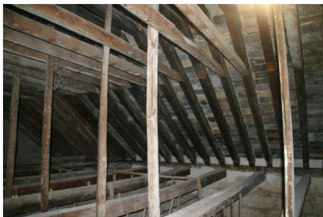
Figura 2.20: Detalle de los restos la armadura primitiva del templo (Fuente: fotografía de Rafael Salido).
