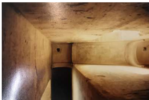
Figura 3.74: Detalle de las bóvedas de la escalera de la torre. (Fuente: A.C.C.C.P.H.A. A9.004/14, s.f.).
