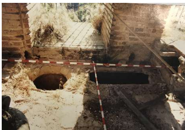
Figura 3.80: Detalle del suelo del campanario. (Fuente: A.C.C.C.P.H.A. A9.004/14, s.f.).
