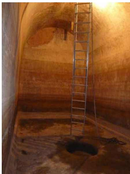
Figura 3.102: Interior del aljibe. (Fuente: fotografía de Rafael Salido).
