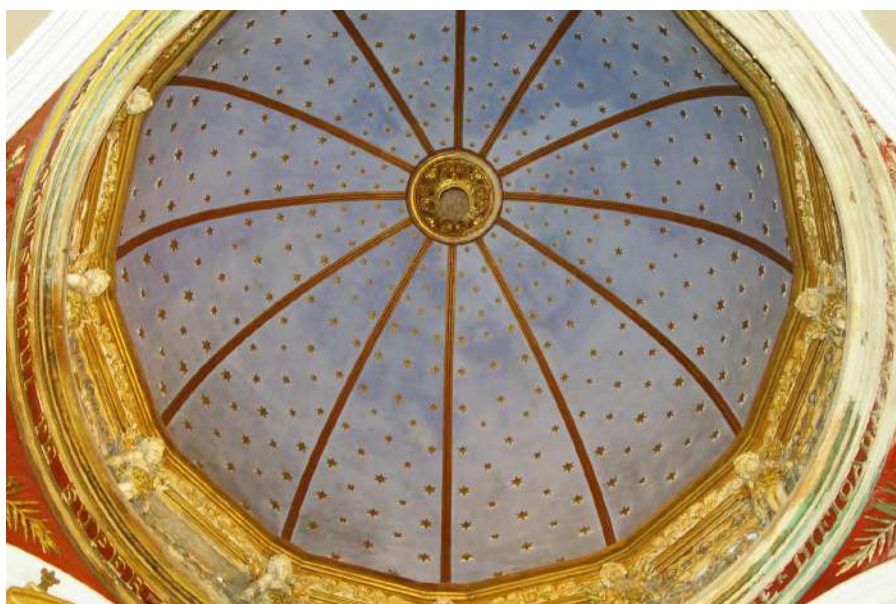
Figura 3.60: Cúpula de la nueva Capilla de San José. (Fuente: fotografía de la autora).
