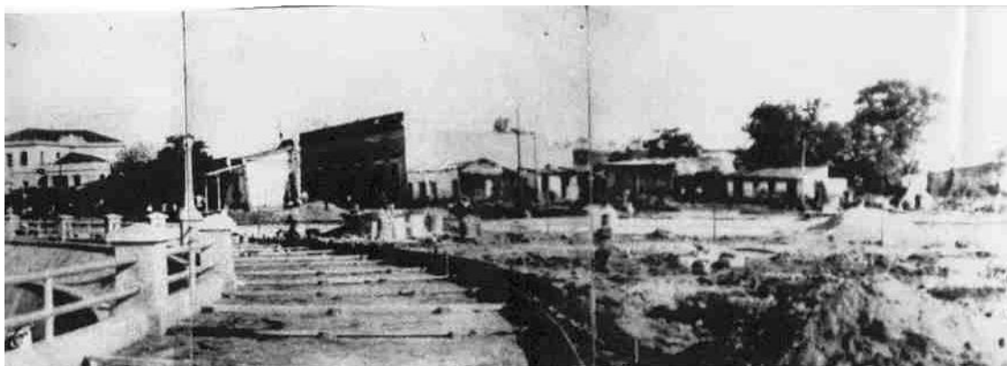
Imagen 4.30: Construcción de la Costanera Gral. San Martín 1er tramo entre 25 de Mayo y Pellegrini aprox. Cercano a la desembocadura del arroyo Salamanca. Fuente: Fototeca del Archivo Histórico Provincial.
