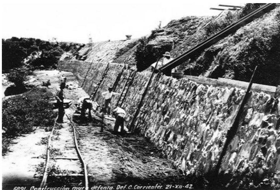
Imagen 4.32: Construcción de muro de defensa sobre la Barranca. Fuente. MOP, 1942.
