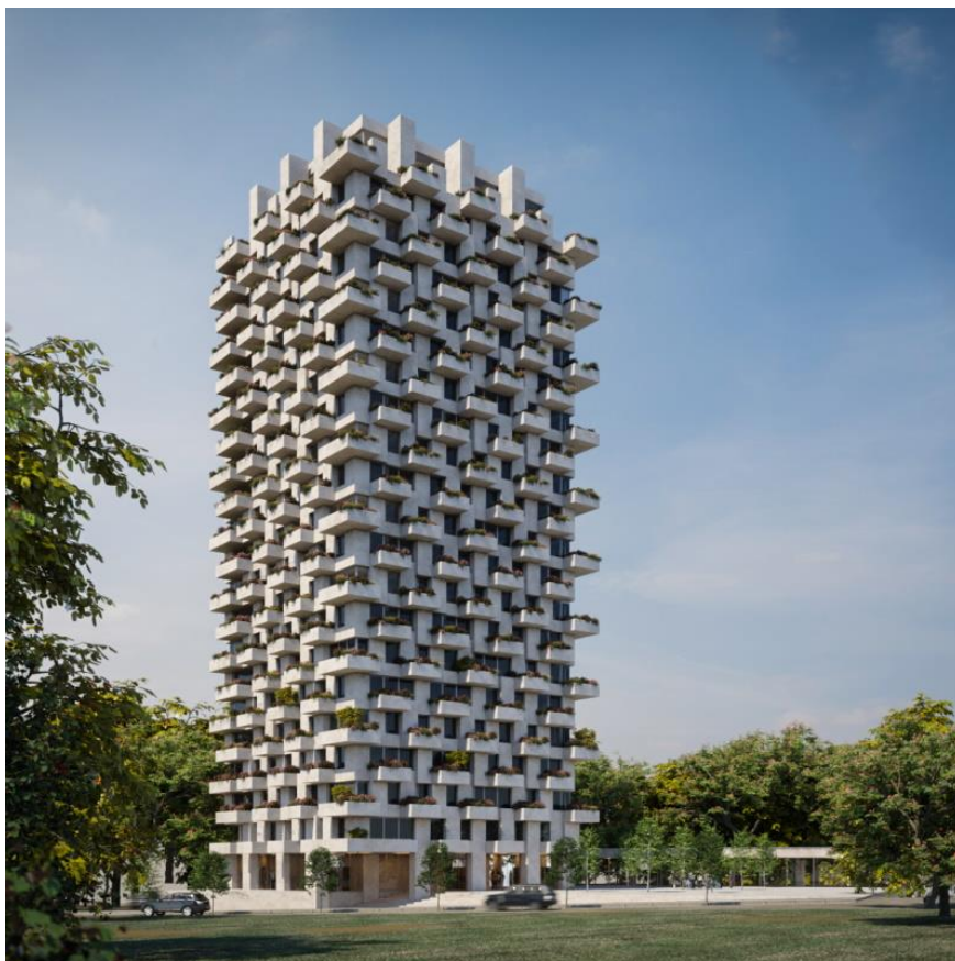
Figura 4.1 - Edifício de estudo para a implementação de um sistema AVAC.
