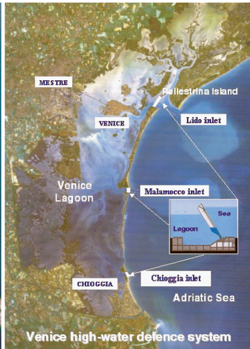
Figure 3. The Modulo Sperimentale Elettromeccanico (MOSE).
