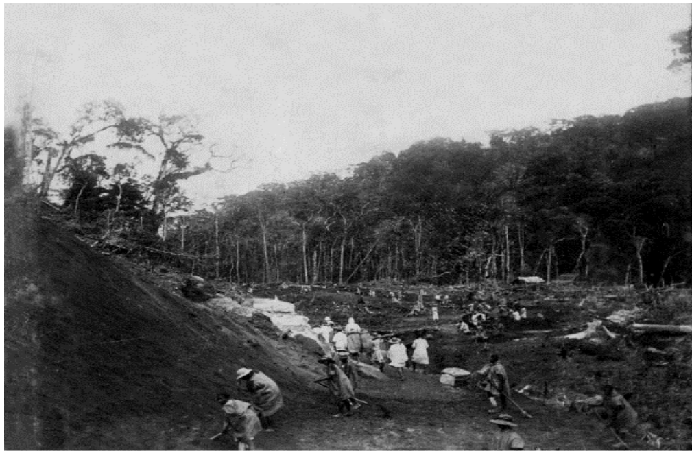
Travaux du chemin de fer près d' Andasibe Analamazaotra (1903)
