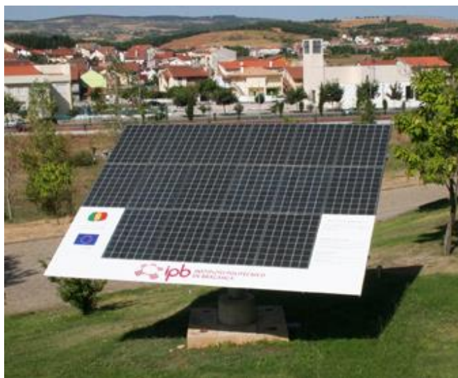
Figura 23 - Fileira do seguidor solar [41].
