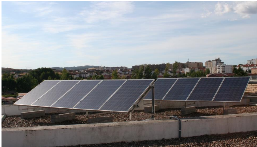
Figura 24 - Fileira da cobertura do LSE.
