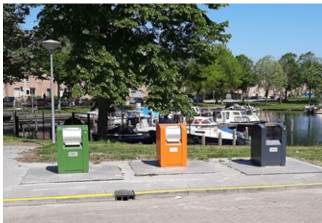
Figuur 4.1.2: Ondergrondse containers in Almere zijn voorzien van een kleur per stroom.
