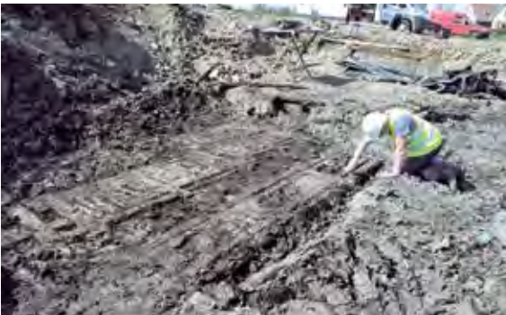
De rasterfundering van de voor- en achterwaterloop.
