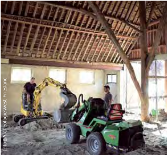
In de stolp is een dunne laag grond afgegraven.
