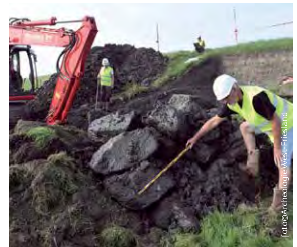
Vermoedelijk is het houten scherm in de 18de of 19de eeuw gesloopt en heeft het plaats moeten maken voor een versteviging van grote brokken noordse keien.
