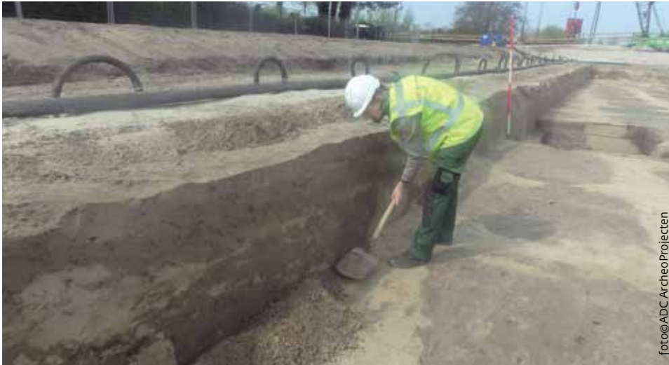
Aan het werk langs het spoor in de oostelijke proefsleuf.
