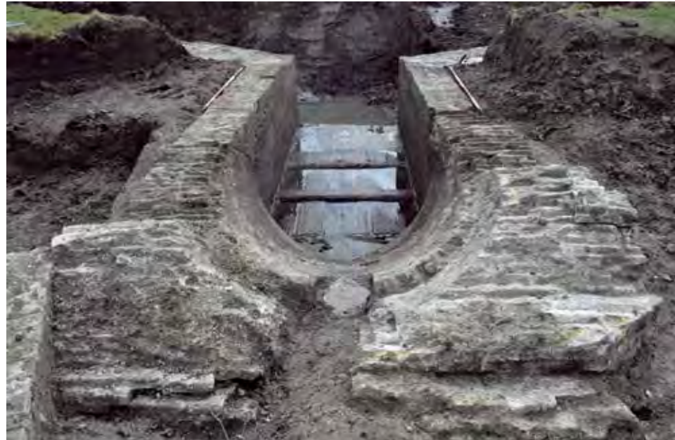
De vloer van de vijzelbak.
