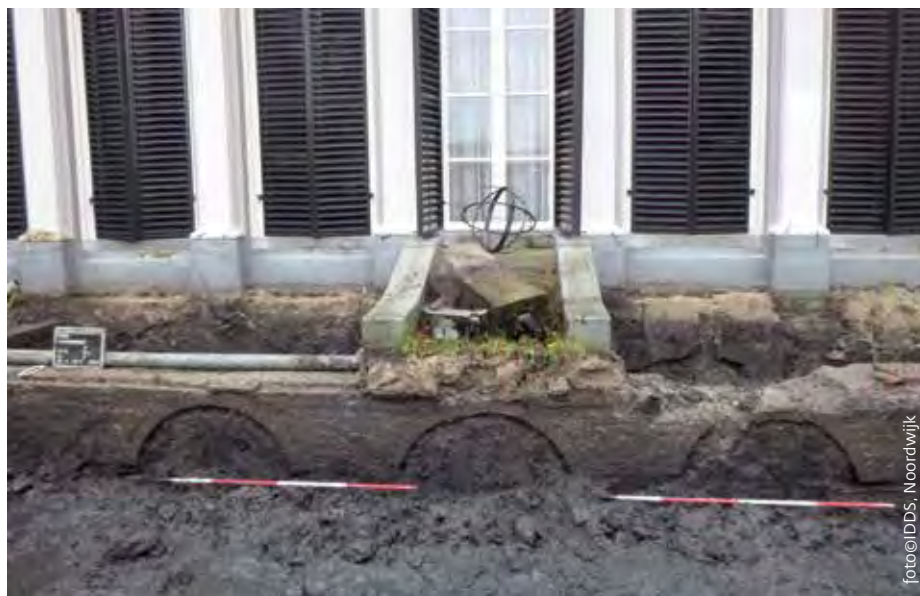
Overzicht van spoor 1 (muur) in werkput 1.
