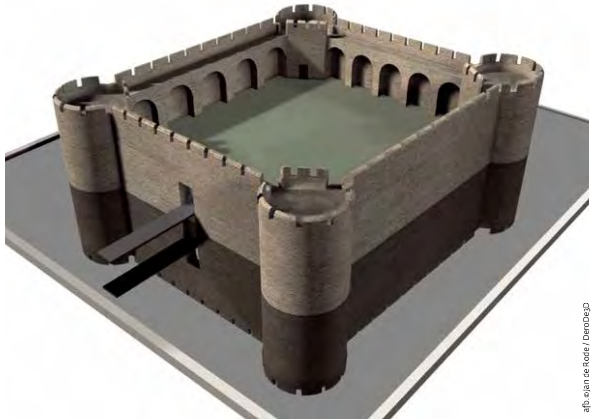
Reconstructie van de oorspronkelijke toestand van het Muiderslot. Er is dan sprake van een "ommuurd kampement" met slechts een eenvoudige poortdoorgang en geen (woon)vleugels tegen de weermuren. De bouwtijd ligt rond 1285. Mogelijk was toen ter plekke al een oudere sterkte aanwezig.
