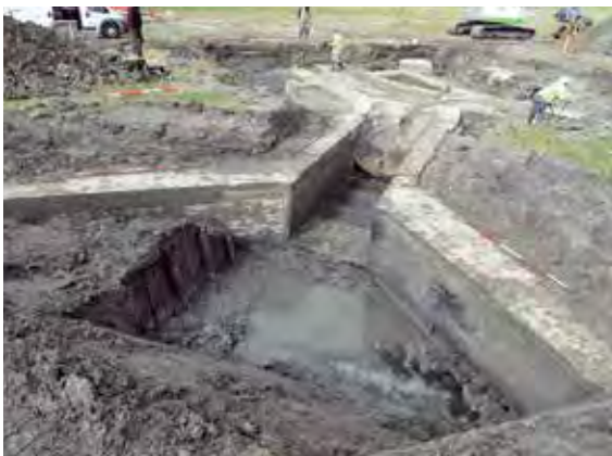
De vijzelbak (midden) en de achterwaterloop van de poldermolen.
