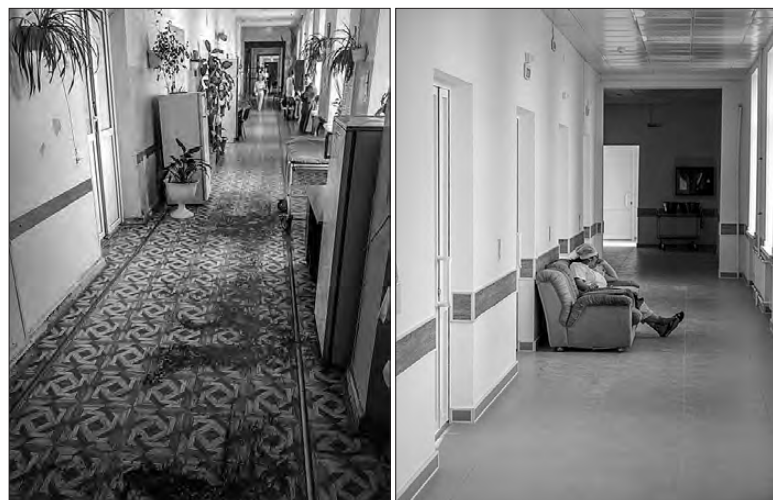
Отделение урологии до ремонта и после ремонта.
