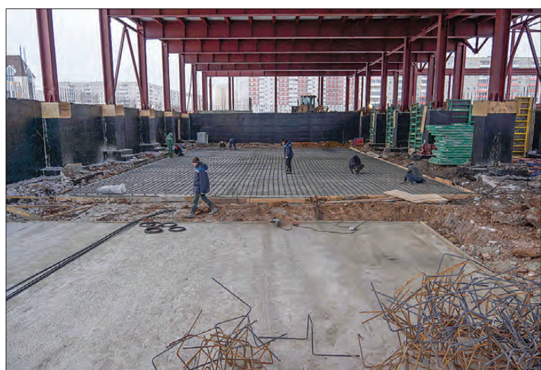
Рабочие армируют чашу бассейна.
