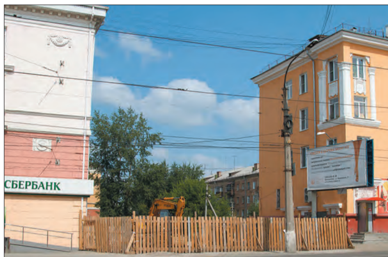
Со стороны дороги стройка смотрится беспроblemно.
