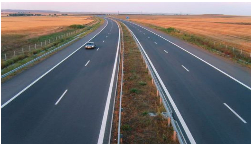
Автомобильные дороги с цементобетонным покрытием
