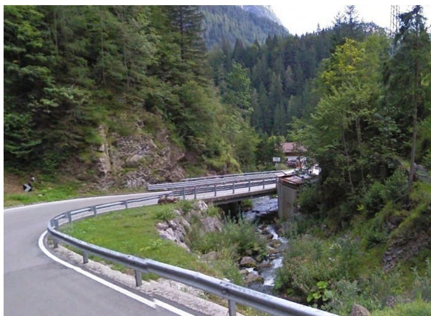
Figura 37 - Ponte a luce ridotta. Opera n°163.
