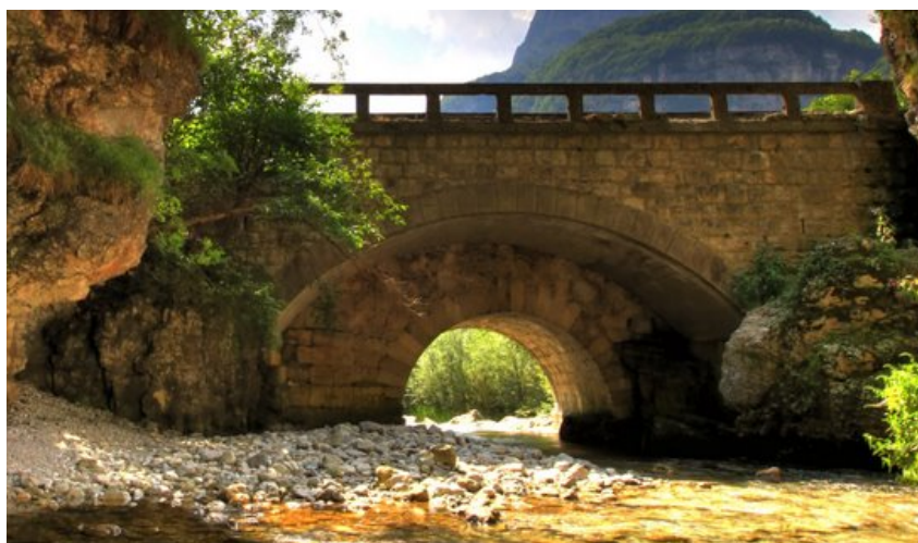
Figura 39 - Ponte a luce ridotta. Opera n°236.
