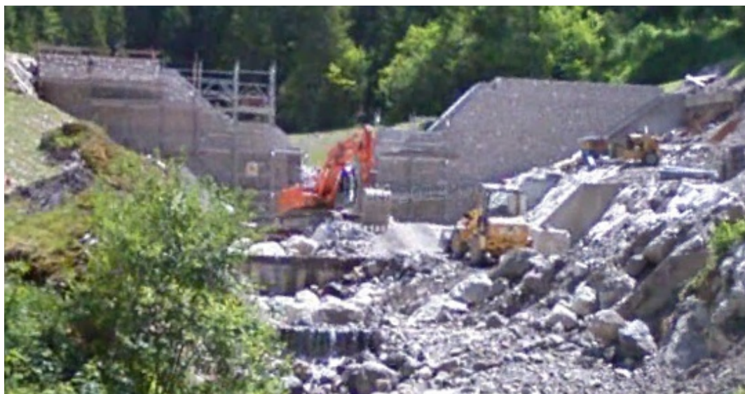
Figura 43 - Briglia filtrante in costruzione sul Ru d'Antersass. Opera n°152. Alleghe.
