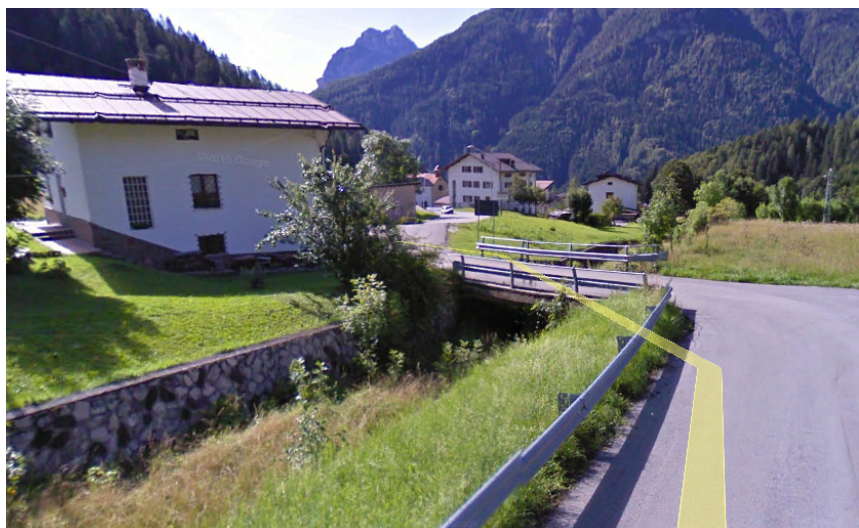
Figura 35 - Ponte a luce ridotta presso l'abitato di Toffol. Opera n°183.
