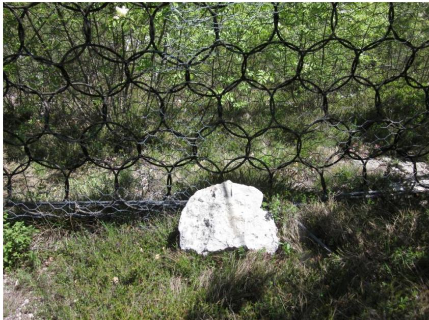
*Figura 64 – masso intercettato dalle barriere con diametro di 50cm circa e volume pari a 0.125mc.*
