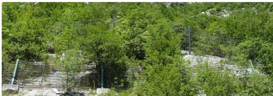
Figura 89 – Visione di alcune barriere paramassi attualmente presenti in prossimità dell'entrata in galleria della strada statale. Si distinguono le due tipologie di barriere: rigide (davanti) ed elastiche (dietro).
