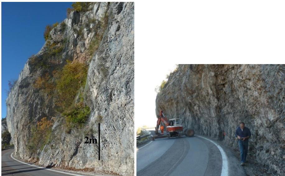
*Figura 43 – Elemento nr. 1 e 2: visione delle condizioni di intensa fratturazione dell'ammasso roccioso in prossimità della strada statale.*
