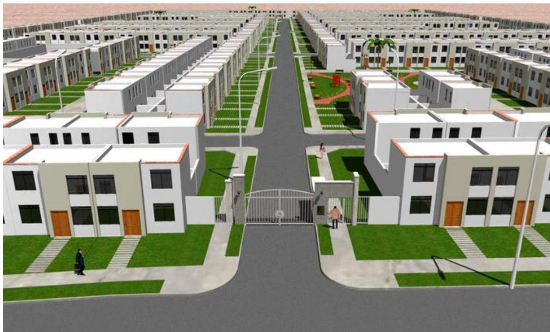
Imagen 22. Urb. San Francisco. Control de ingreso.
