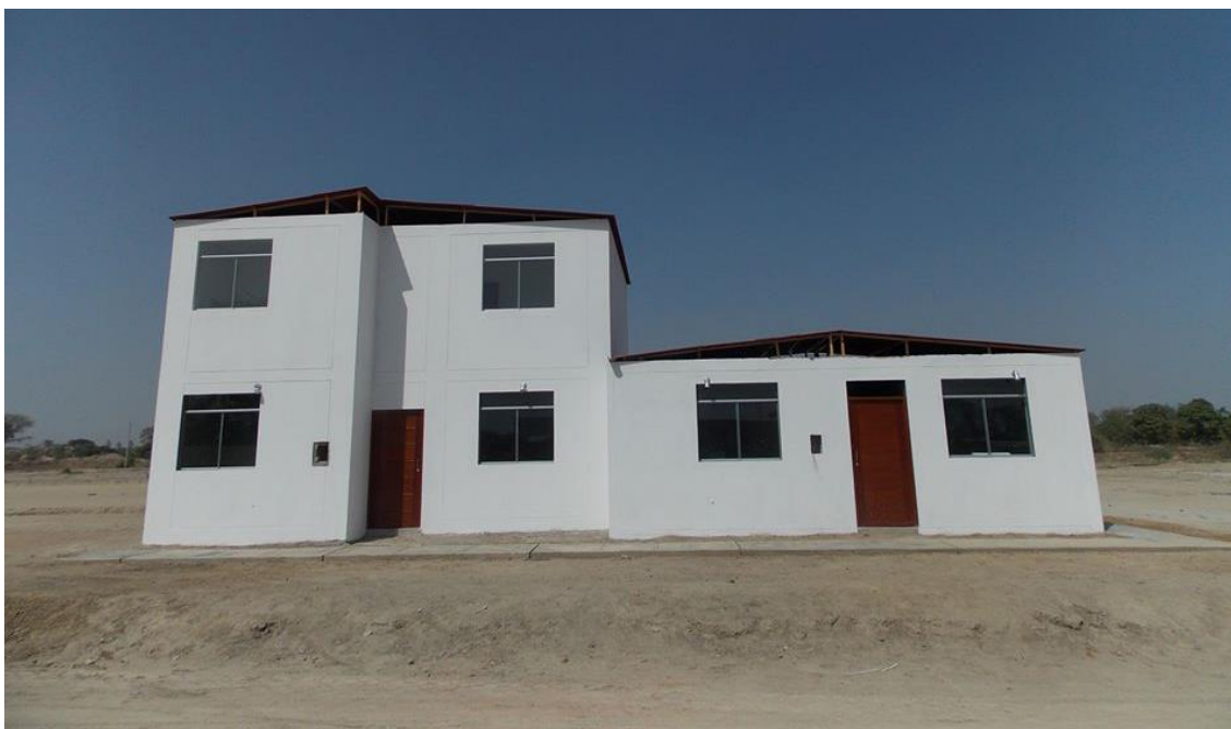
Imagen 21. Proyecto Valle Camila. Módulos de vivienda.
