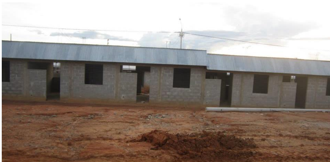
Imagen 13. Proyecto Nuevo Horizonte. Situación de las viviendas entregadas.
