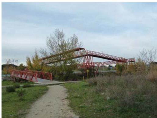
Imagen 5. Puente peatonal sobre la autopista.
