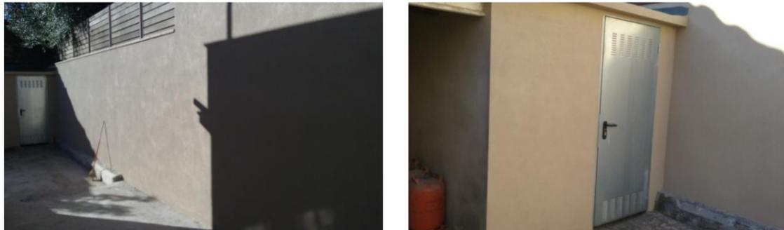
Este tipo de acabado se ha puesto en las paredes con revoco exterior, en la fachada del almacén y en los muros colindantes con los vecinos encima del revoco ya existente.
