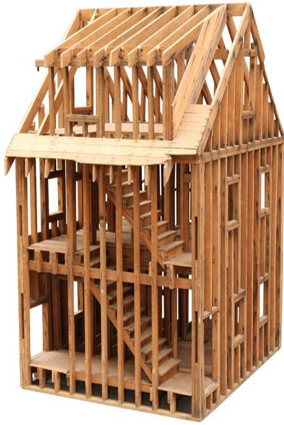
Fig. 4.13- Estructura balloon frame Fuente: Google imágenes
