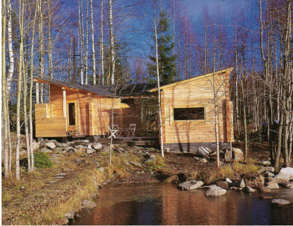
Fig. 5.8 Sauna rural vista desde el lago Fuente: Arquitectura técnica en madera
