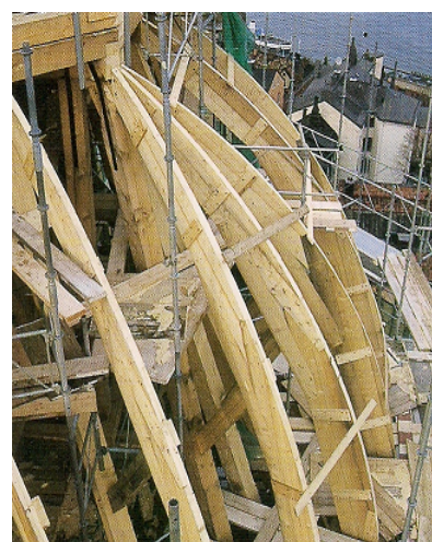
Fig. 5.3 y 5.4 Cabrios de la cúpula y correspondiente entablado. Fuente: Arquitectura nórdica en madera
