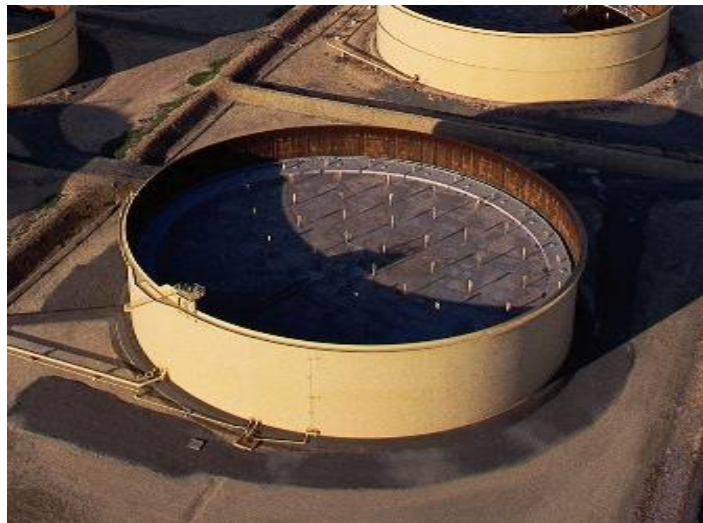
· Imatge 22: Tancs de sostre flotant
