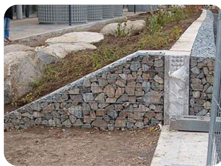
Image 59. Petite digue à côté du fleuve
