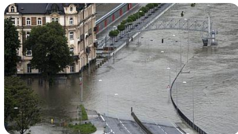
Image 20. Inondation des réseaux d'eau.
