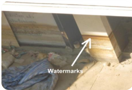
Image 45. Images des marques d'eau sur le mur et les sédiments qui restaient après l'inondation.
