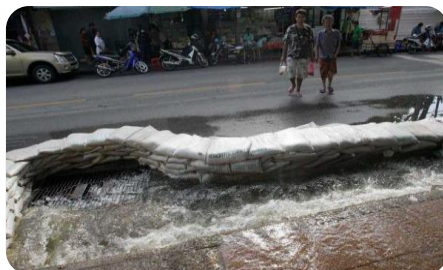
Image 47. Sacs de terres utilisées comme à solution d'urgence pour empêcher l'eau de passer
