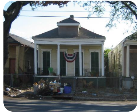
Image 34. Les bâtiments se trouvaient situées 1-2 pieds au-dessus du niveau de la terre.
