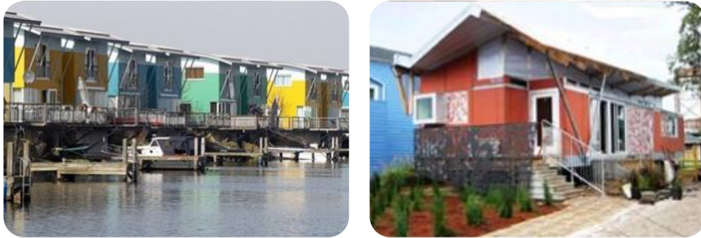
Image 84.. Bâtiments amphibies dans la ville de Maasbommel (Pays Bas) à gauche et dans la ville de Nouvelle-Orléans (Louisiane, USA), à droite.
