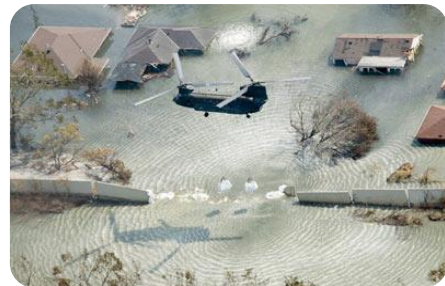
Image 100. Défaillance des digues
