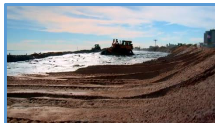
Image 49. Barrières de terre pour empêcher l'eau de passer
