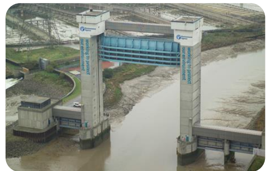
Image 92. La barrière Barking située au fleuve Roding
