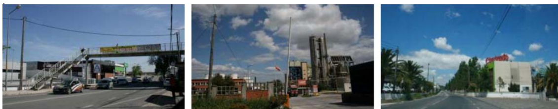
Fig. 23-25: Vistas da ocupação marginal ao longo da estrada nacional EN10: Bobadela, Alverca e Alhandra. Fonte: elaboração própria, 2012.
