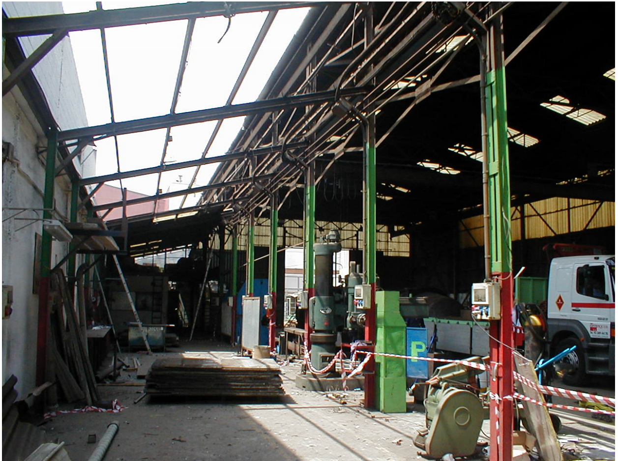
Nave adosada a nave principal a demoler.
