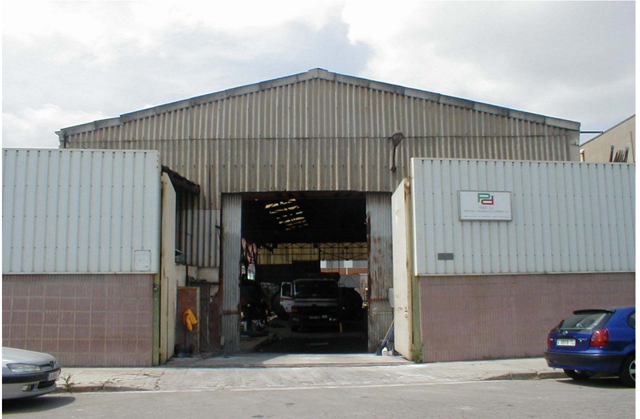
Fachada de la nave industrial existente, vista desde la calle Guifré.
