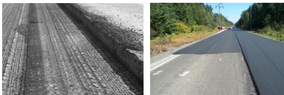
Figura 2.5 Aspecto del asfalto tras fresado (Rasmussen, 2004) (a) y aplicación de asfalto para nivelación (b)
