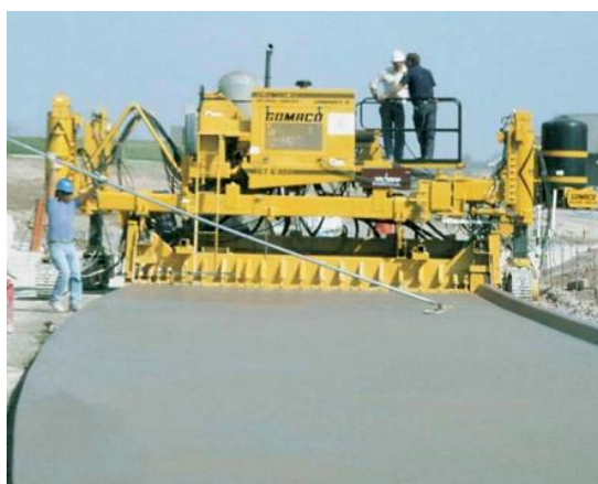
Figura 2.3 Extendidora de encofrado deslizante. Imagen extraída de GOMACO International.
