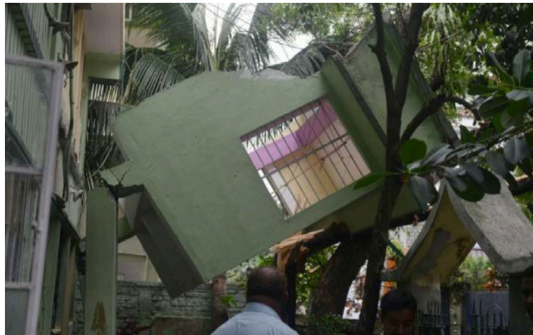
Ilustración 14 Casa derrumbada a causa de un terremoto
