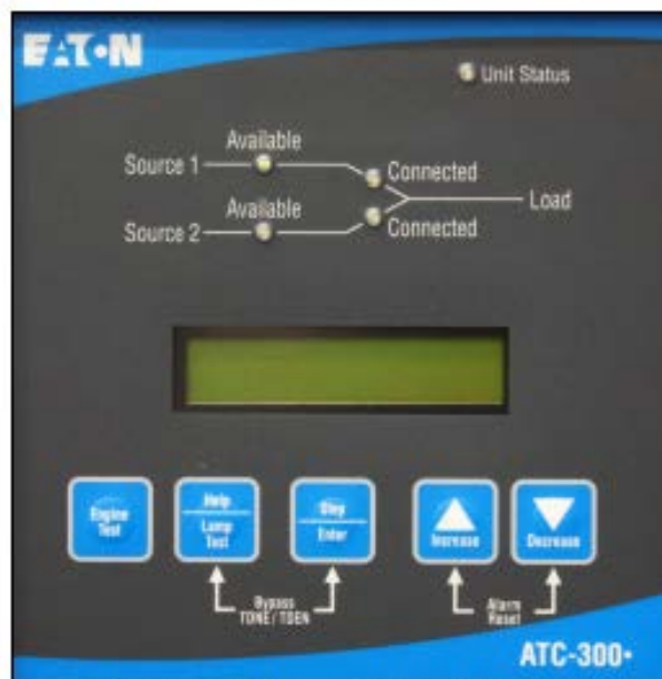
Figura 1. Panel delantero del controlador ATC-300+.
