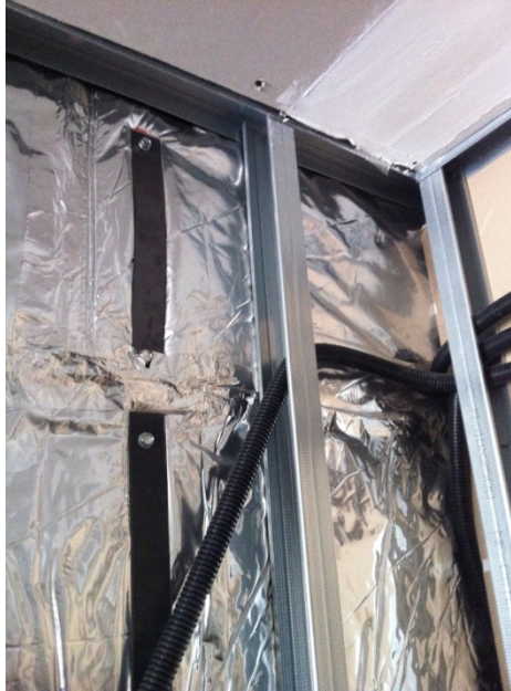
Ilustración 102 Interior de un contenedor
