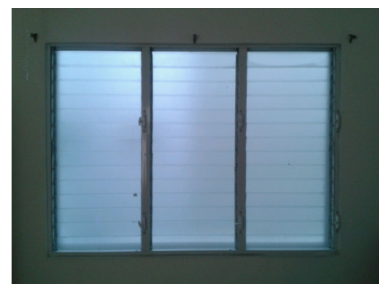
Figura 51. Ventanas de Celosías de vidrio templado, orientadas a un patio de ventilación, Villa Progreso La Fe. Fotografía propia
