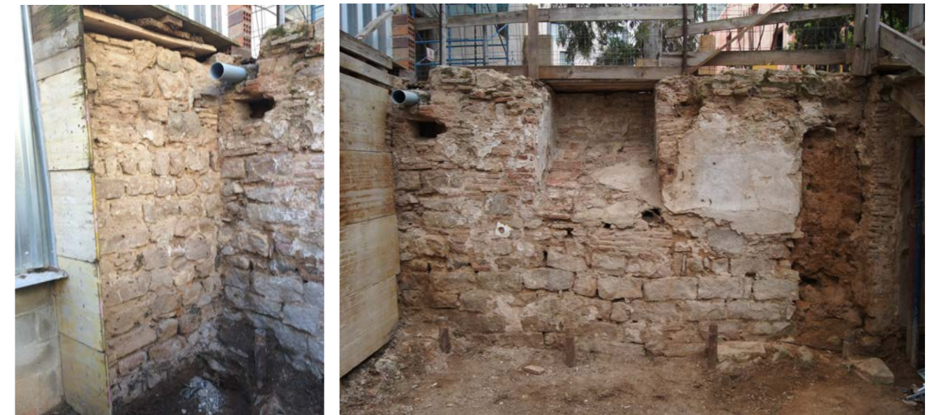
Figura 48: Pilastra de l'aqüeducte Romà (esquerra) i mur de contenció de terres jardí romàntic (dreta) (Font pròpia)
