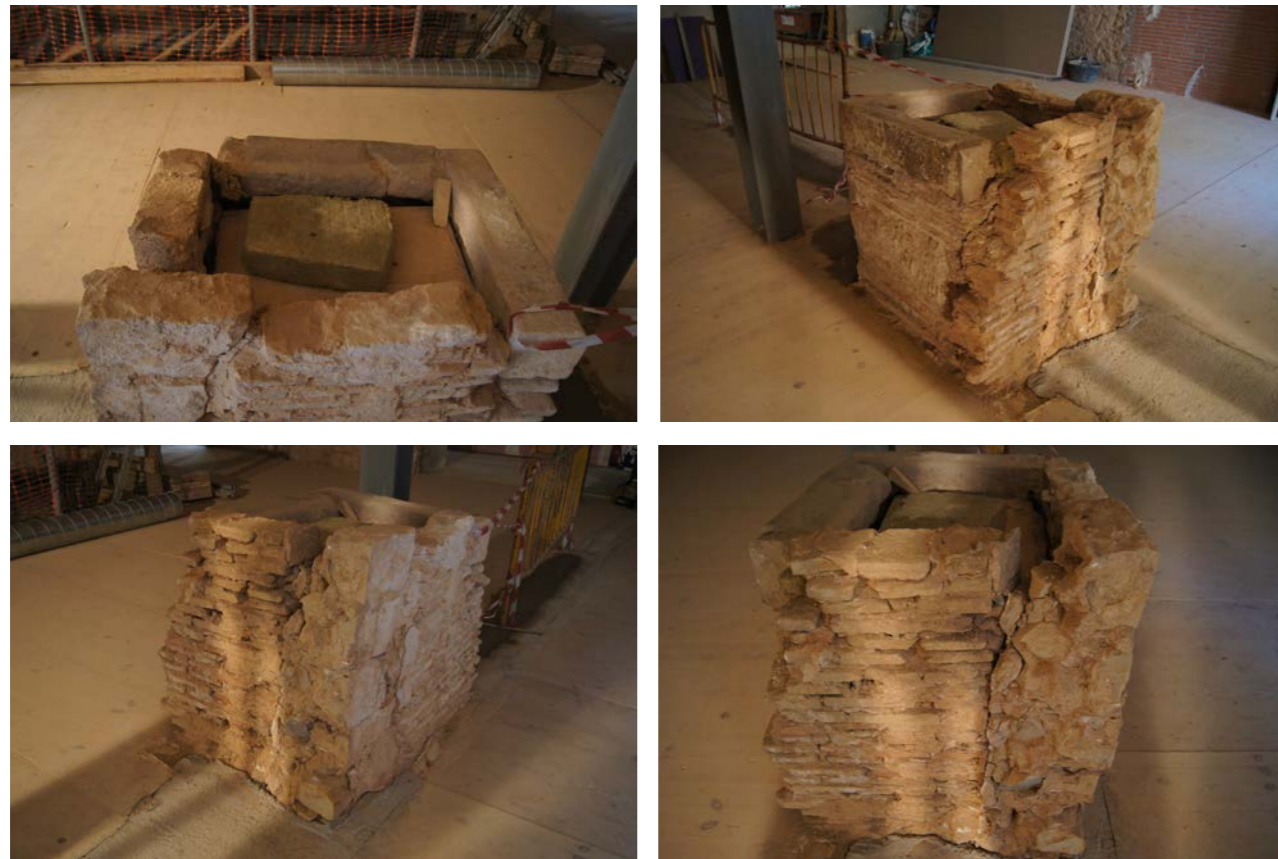
Figura 55: estat del pou abans de la intervenció (Font pròpia)
