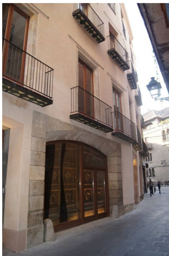
Figura 22: 3a fase: Rehabilitació de la façana del carrer Ripoll (Font: Projecte As Built de reforma de la planta baixa de l'edifici del carrer Ripoll, 25 destinat a equipament sociocultural – Milliores Façanes)
