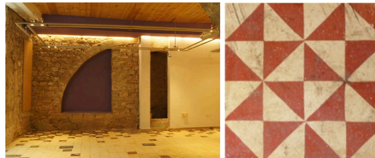
Figura 59: peça de mosaic hidràulic utilitzada per indicar els indrets on es troben restes arqueològiques (Font: Projecte As Built de reforma de la planta baixa de l'edifici del carrer Ripoll, 25 destinat a equipament sociocultural)
