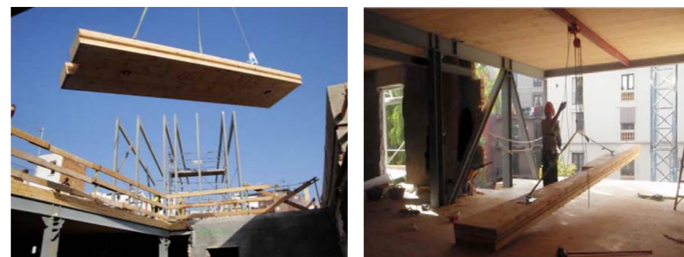
Figura 17: 1a fase: Procés de muntatge dels sostres (Font: Article AITIM)
