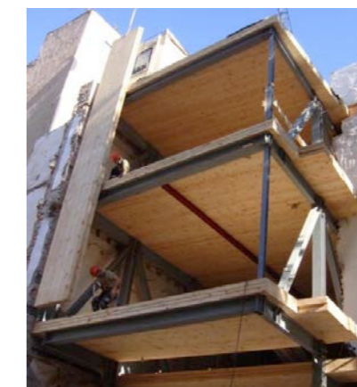
Figura 19: estructura metàl·lica per a sustentar els dos metres de volada de la zona de l'aqüeducte (Font: Article AITIM)
