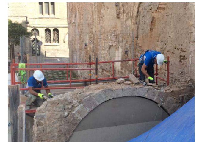
Figura 43: desmuntatge de les pedres que es troben al voltant de les dovelles de l'arc (Font pròpia)
