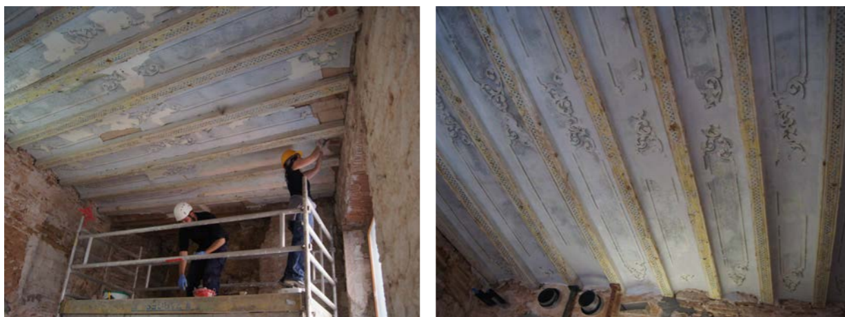
Figura 57: inici de la restauració de sostres (esquerra) (Font pròpia), restauració del mateix sostre finalitzada (dreta) (Font pròpia)
