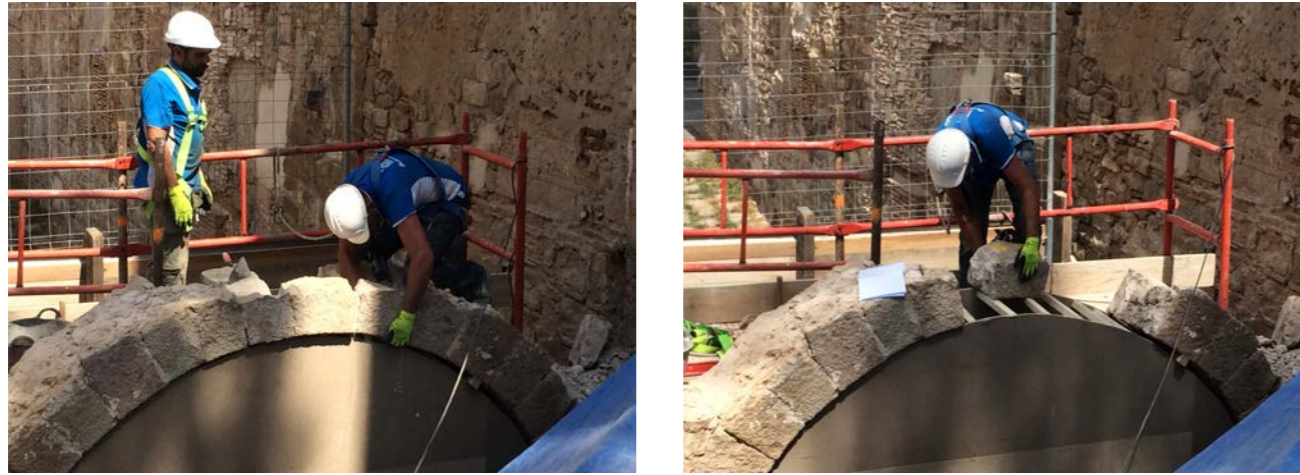
Figura 44: desmuntatge de les contraclaus i la clau de l'arc (Font pròpia)
