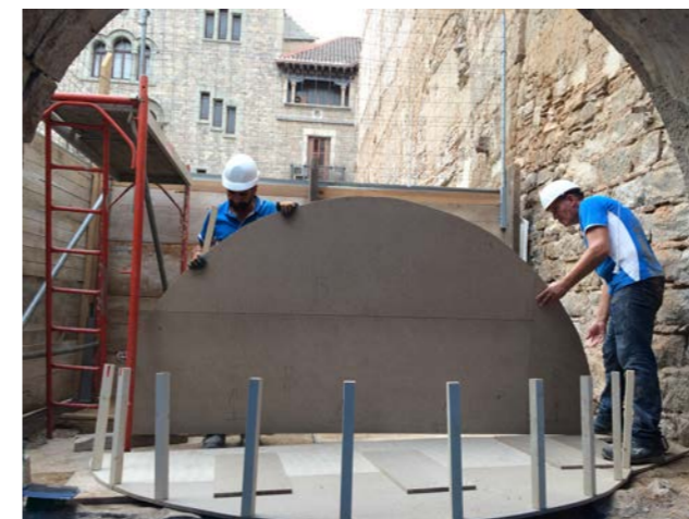
Figura 42: execució de la cintra per a procedir amb el desmuntatge de l'arc (Font pròpia)
