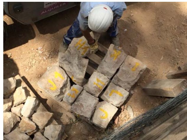
Figura 45: classificació de les dovelles, contraclaus i clau que formen l'arcada de l'arc (Font pròpia)
