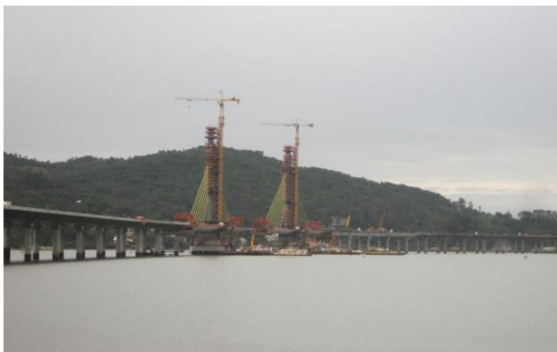
Figura 03: A ponte e os vãos estaiados em construção
