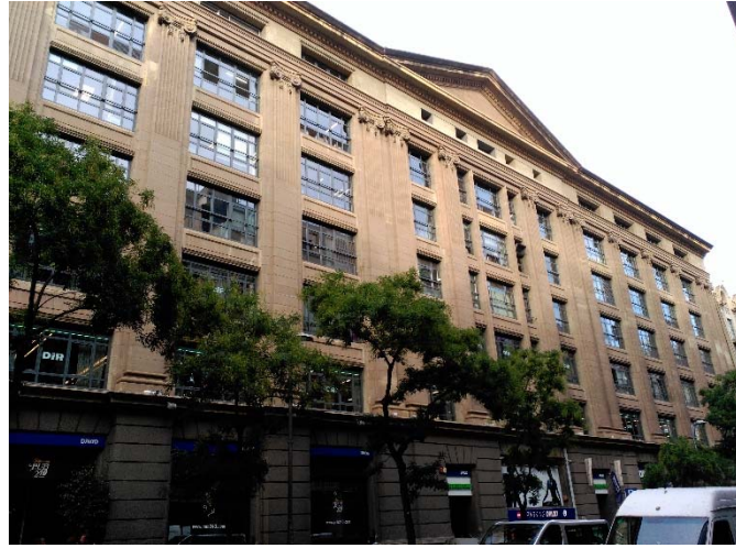
Edifici David - Barcelona
