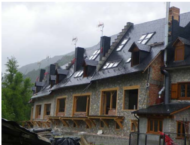
Figura 15. Ejemplo de edificación de la tipología T3.
