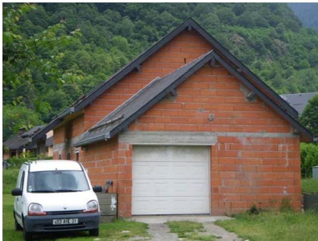
Figura 14. Ejemplo de edificación de la tipología T2
