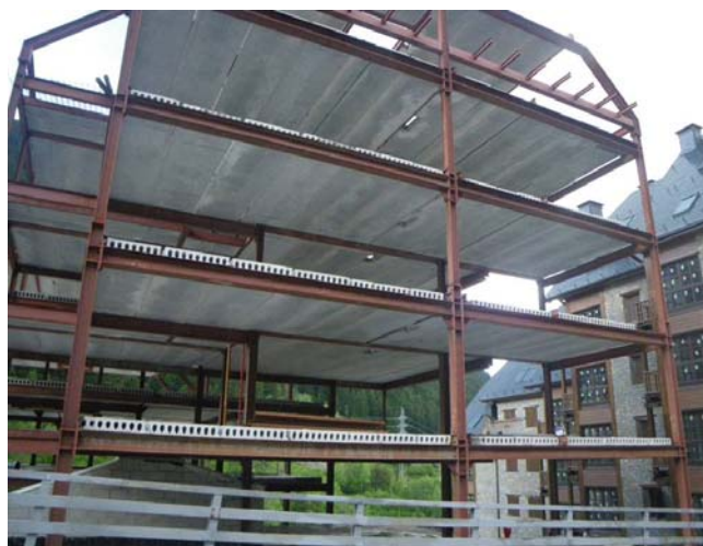
Figura 17. Ejemplo de edificación de la tipología T6.
