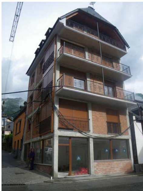
Figura 16. Ejemplo de edificación de la tipología T4.
