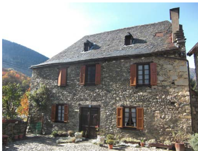
Figura 13. Ejemplo de edificación de la tipología T1.
