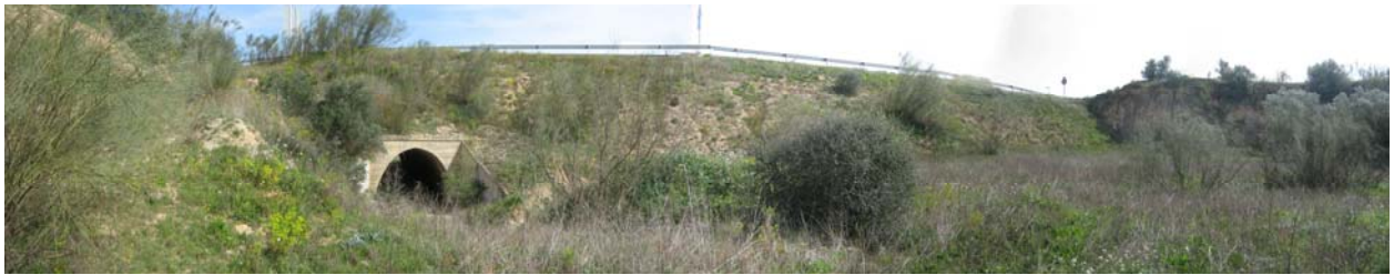
17 - Vista des d'aigua amunt de l'obra de drenatge de la carretera C-12 al barranc de la Peixera. La llera queda completament encaixada en aquest punt.
