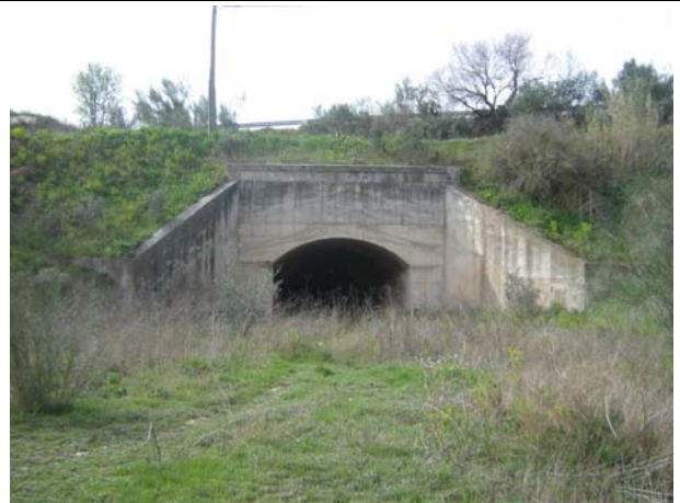
13 - Vista des d'aigua avall de l'obra de drenatge de la carretera C-12 al seu pas pel barranc de la Peixera.
