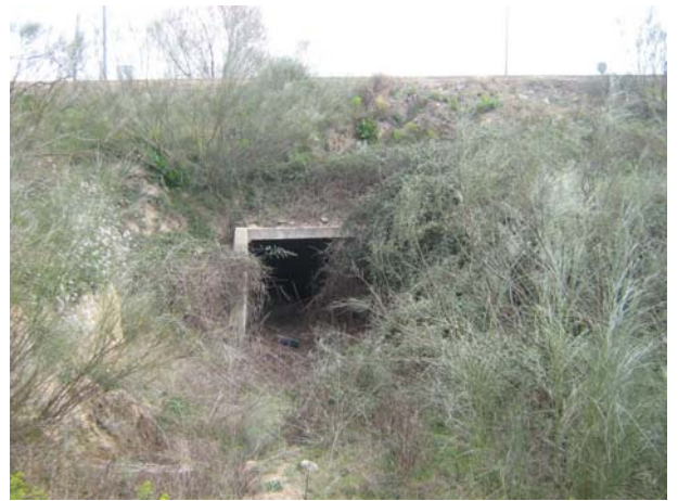
02 - Vista cap aigua avall de l'entrada de l'obra de drenatge de la carretera d'accés a la central nuclear d'Ascó.
