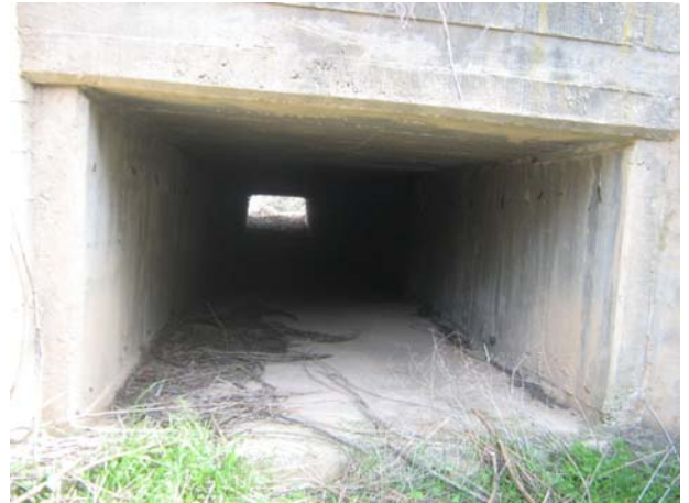
26 - Obra de drenatge de la carretera C-12 al barranc de Los Aubals.
