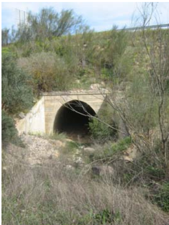
18 - Vista des d'aigua amunt de l'obra de drenatge de la carretera C-12 al barranc de la Peixera.
