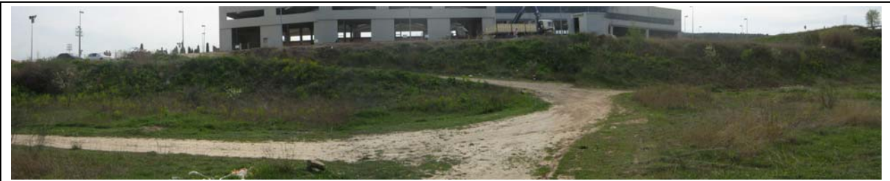
14 - Marge dret del barranc de la Peixera, aigua avall de l'obra de drenatge de la carretera C-12.
