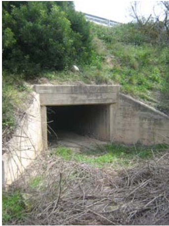
25 - Entrada de l'obra de drenatge de la carretera C-12 al barranc de Los Aubals.
