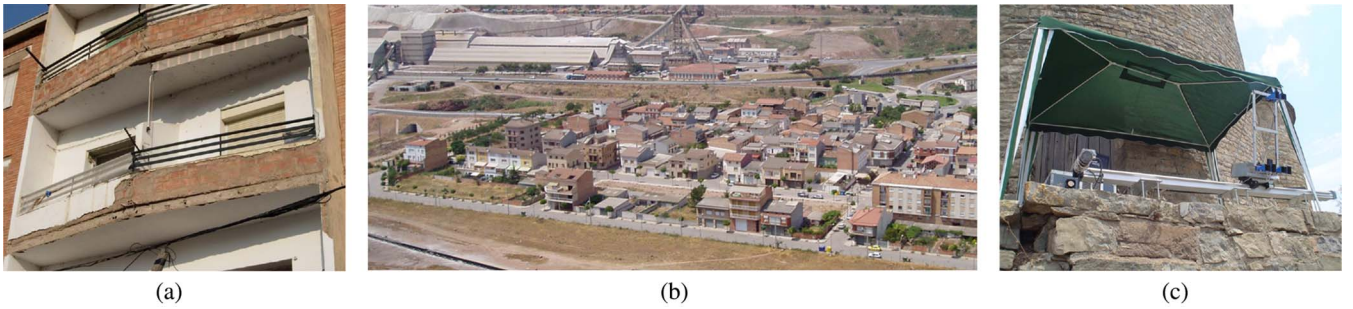
F1:1 Fig. 1. (a) Example of the heavy damages observed in El Barri de l'Estació, Sallent . (b) Picture of the El Barri de l'Estació observed from the (c) RiskSAR point F1:2 of view.
