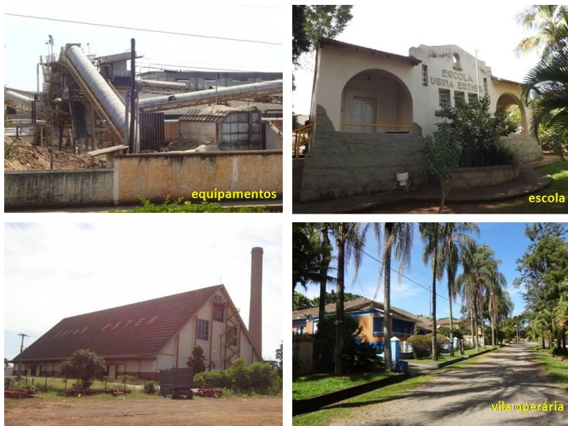
Figuras 13. Conjunto de construções e equipamentos da Usina Ester. Fonte: Foto do acervo da pesquisa, 2013.
