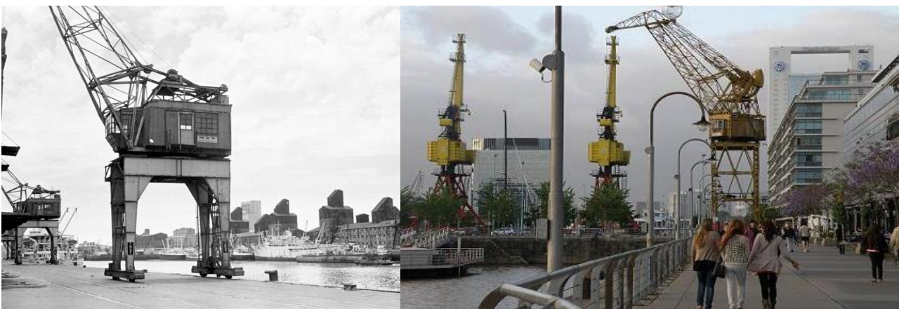
Imagen de las Grúas antes y después de la renovación.
