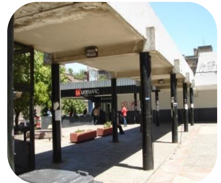
Pasarelas Zócalo Pedregal.
