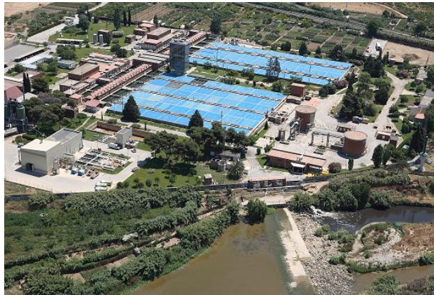
Fig. 4 Foto de las instalaciones de tratamiento de fangos
