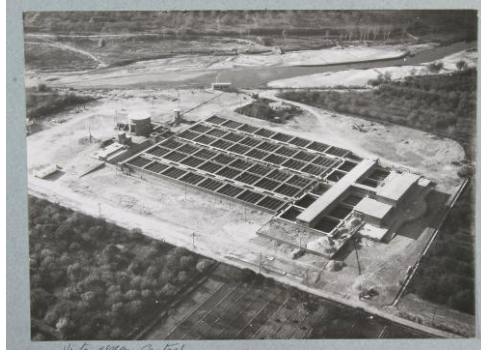
Fig. 1 Foto de las obras año 1955
