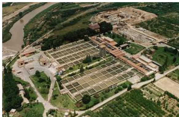
Fig. 3 Foto de las obras año 1992
