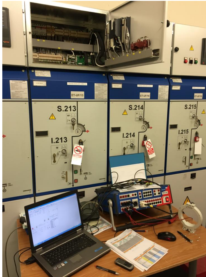
Fig. 7 Foto de la revisión del interruptor I.213
