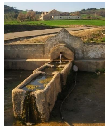
Foto 9: Pilar en "Las Capillas" con pila para el ganado. Fuente: Propia.
